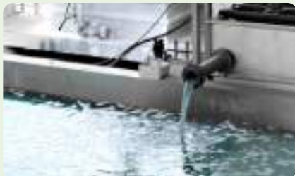
TRATAMIENTO DE AGUAS RESIDUALES
